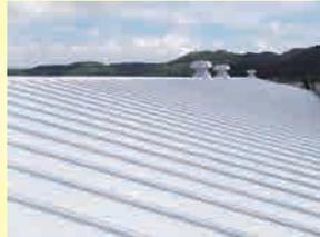
折板屋根 耐腐食防水遮熱塗装
