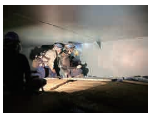
槽内検査 (膜厚検査ピンホール検査等)
