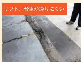
搬入口などスロープ作成
