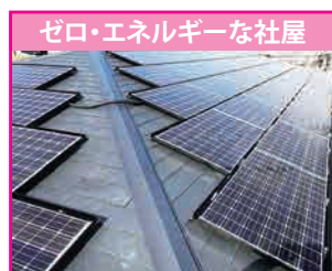
屋根に太陽光パネル (82 枚分) の設置
