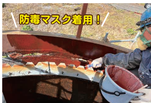
食品加工工場廃水タンク防食ライニング工事の様子
