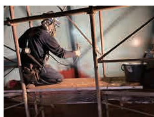
フレークライニング防食塗装 (エアレススプレー吹付)
