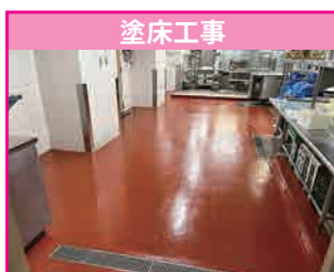
環境に配慮した工事 (HACCAP 対応)
