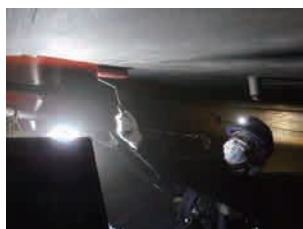
鋼板面プライマー塗布
