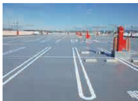
家電量販店屋上駐車場 防水工事
