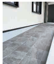
店舗前のスロープ
