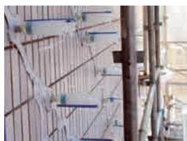
ビジネスホテル 壁面クラック補修工事
