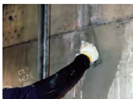
某私鉄地下駅構内 躯体補修工事
