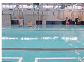
某自動車メーカー整備工場 塗床工事
