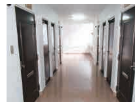
マンション共用部分改修工事
