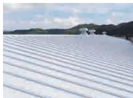
折板屋根 耐腐食防水遮熱塗装
