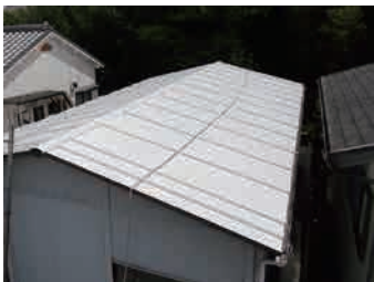
資材倉庫屋根
