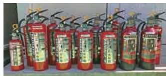
消火器の点検を実施
