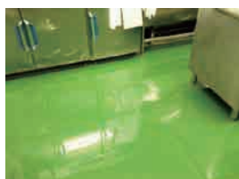
リゾートホテル厨房 塗床工事
