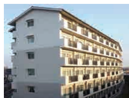
マンション外壁改修工事
