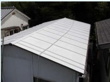
屋根表面の温度が最大約23℃削減されることにより、室内温度が最大約2.5℃削減します。
