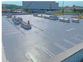
ホームセンター屋上駐車場 防水工事
