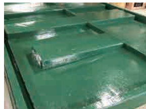
熱源機械室架台 防塵塗装工事
