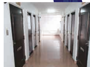
マンション共用部分改修工事
