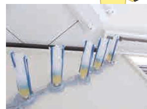
某駅ビル 壁面クラック補修工事
