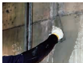
某私鉄地下駅構内 躯体補修工事
