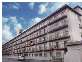
マンション外壁改修工事
