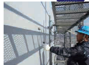
マンション外壁塗装工事
