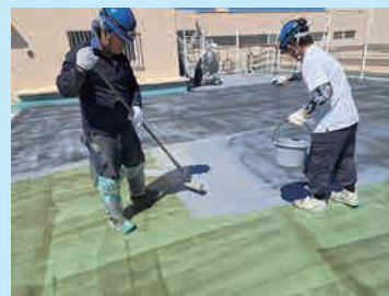
屋上駐車場防水工事
