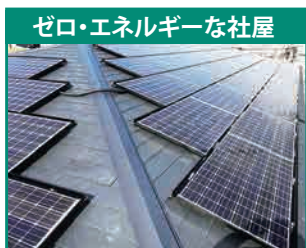
屋根に太陽光パネル (82枚分)の設置
