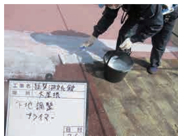
プライマー塗布
