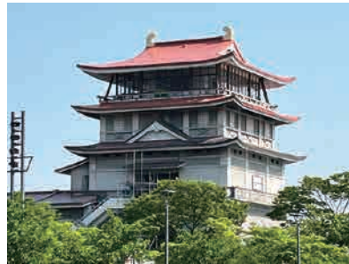
琵琶湖文化館 大屋根防水改修工事
