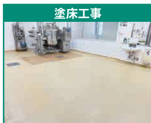
環境に配慮した工事 (HACCP対応)
