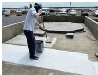
ロービングクロス 貼付
