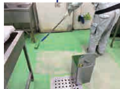
骨材散布 MMA 樹脂上塗り
