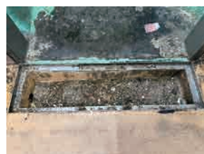
側溝のコンクリートの腐食
