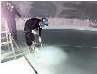
NK フレーク N242BM 中塗 底板吹付塗布
